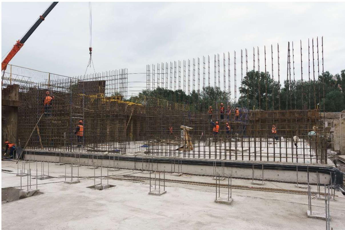
Секция Н2. Окончены работы по устройству основания для ростверка.
