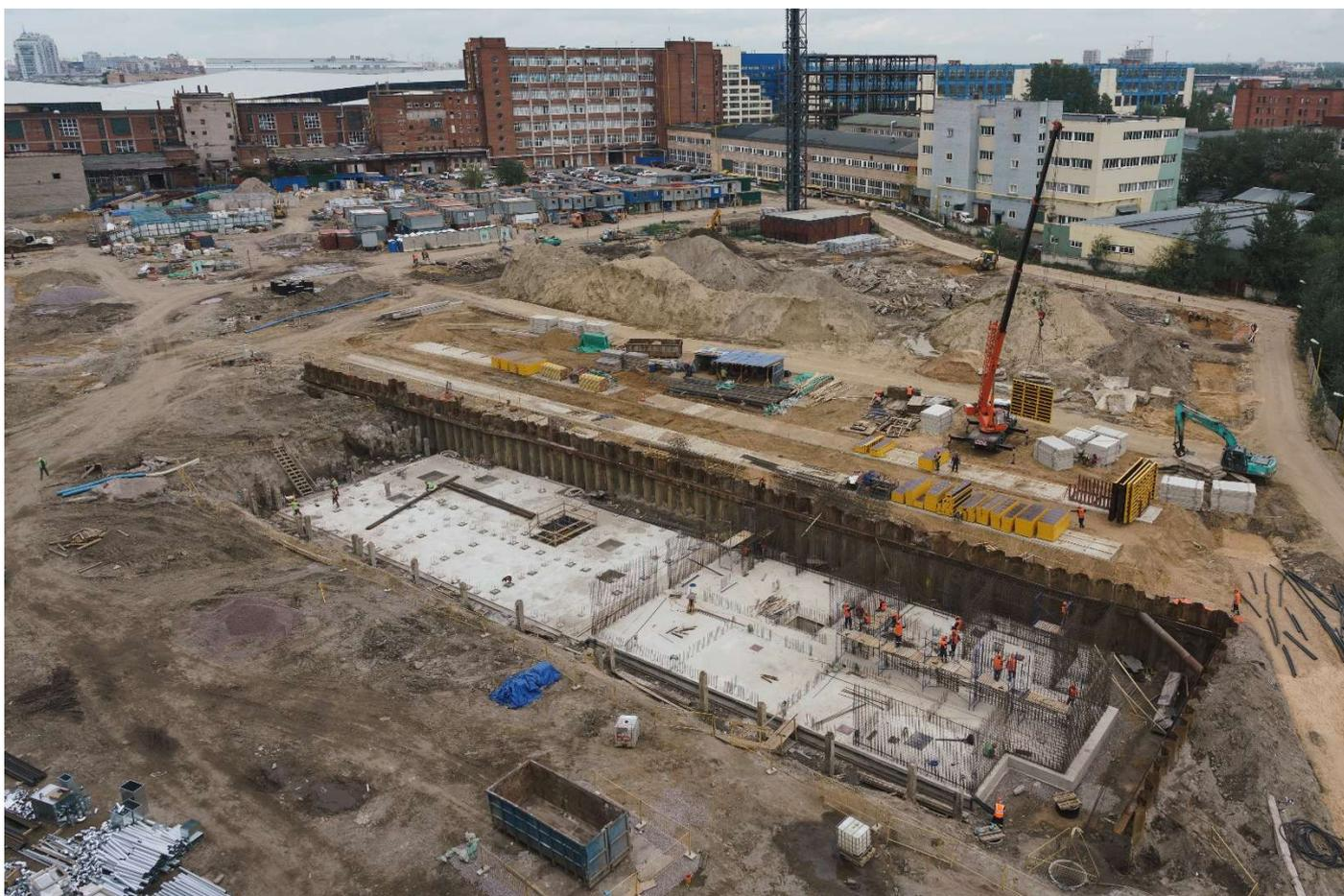
Секция К2. Ведутся работы по устройству монолитных железобетонных конструкций наружных и внутренних стен подвала
