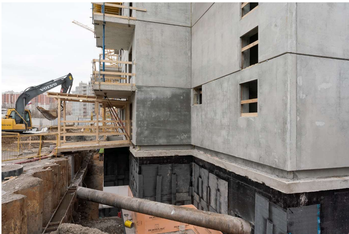
Ведутся работы по устройству гидроизоляции и теплоизоляции стен подвала.
